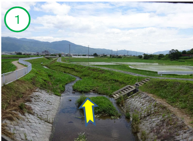
整備完成写真 千代川側道3号線 井根口橋から下流
