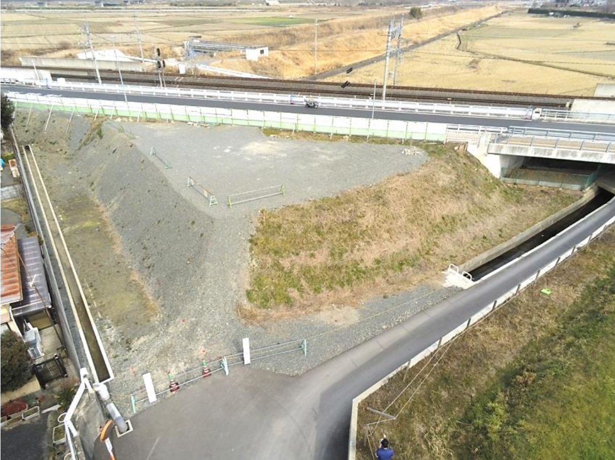
現況写真 ②亀岡市北古世町2丁目189番1
