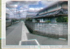
崩れそうな古いブロック
