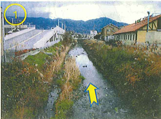
現状写真(未改修) 国道9号 千々川橋から下流 平成23年12月20日 午後3時50分撮影 【JR～国道9号】
