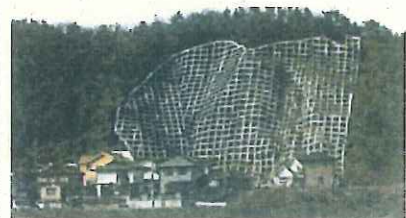
●災害発生危険度の高い地区におけるがけ崩れ対策(岡山県備前市福田)
