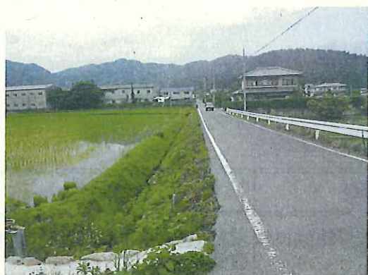
○佐伯鉾山線 路肩拡幅 防護柵設置 路肩カラー舗装
