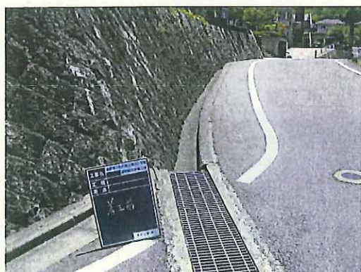
○市道大葉台1号線 水路床板工 車線分離標
