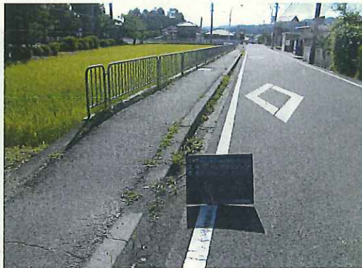
○市道吉川 花 稗田野線 防護柵工設置
