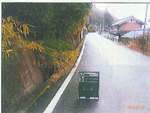
○赤熊青野線 側溝蓋掛け 路肩カラー舗装
