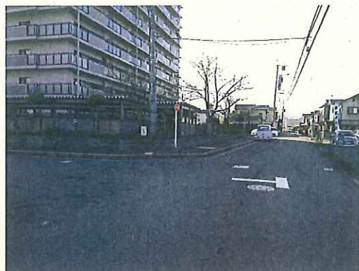
○市道つつじヶ丘56号線 縁石ブロック切り下げ 道路照明工
