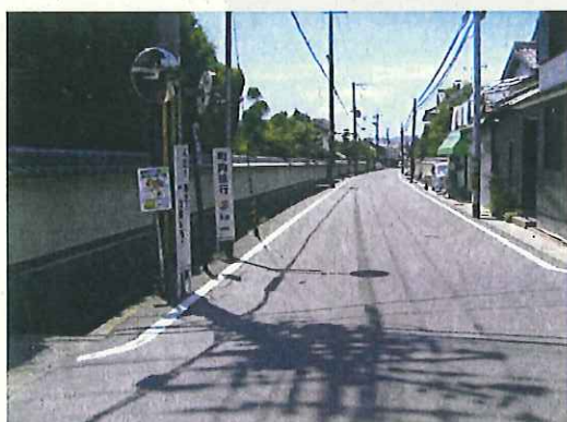
○池尻宇津根線 ガードパイプ設置 路肩カラー舗装
