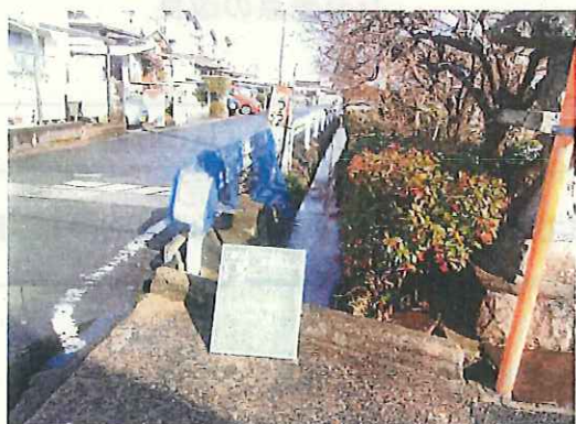
○西嶋線 水路暗渠化 歩車分離 ガードパイプ
