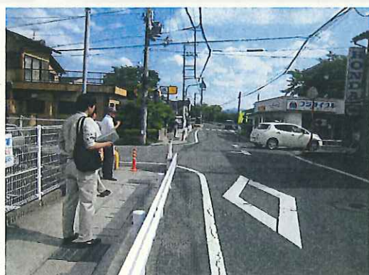
○市道川関小林線 薄層カラー舗装 路肩カラー舗装 区画線引き直し
