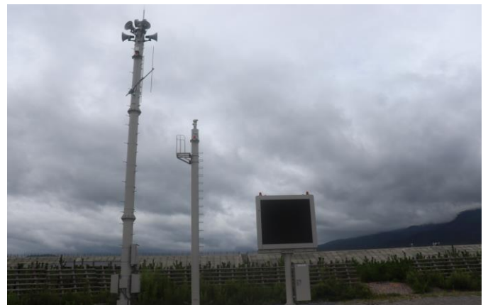
高田松原海水浴場に設置された海岸安全情報伝達装置 （海岸の映像を確認するためのカメラや、大津波警報発令時などに、海岸にいる方に情報を伝達するための装置などが整備されています）
