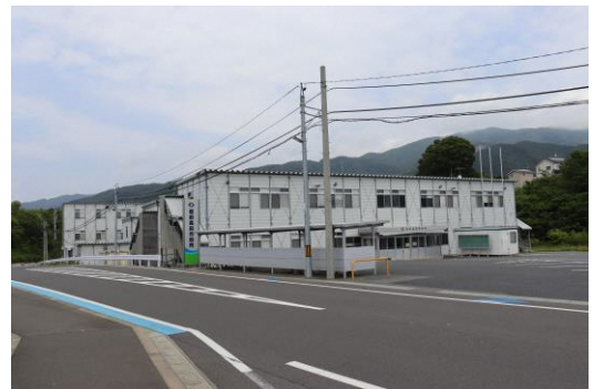
約10年間業務が行われた仮設庁舎
