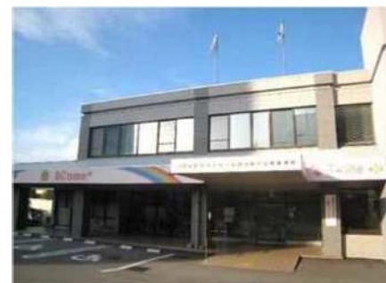
亀岡市保健センター内 1階
