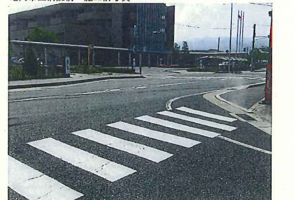
亀岡市立病院前 施工前写真
