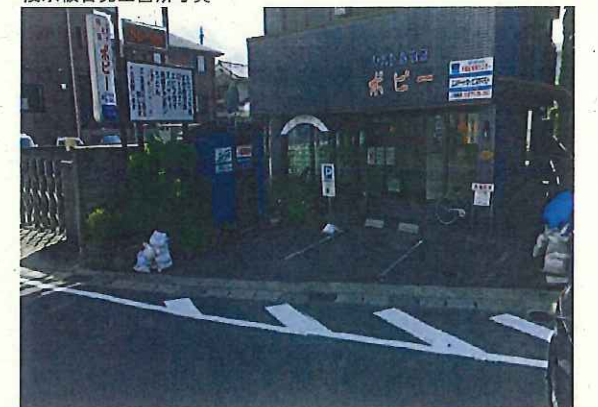
浸水被害発生箇所写真
