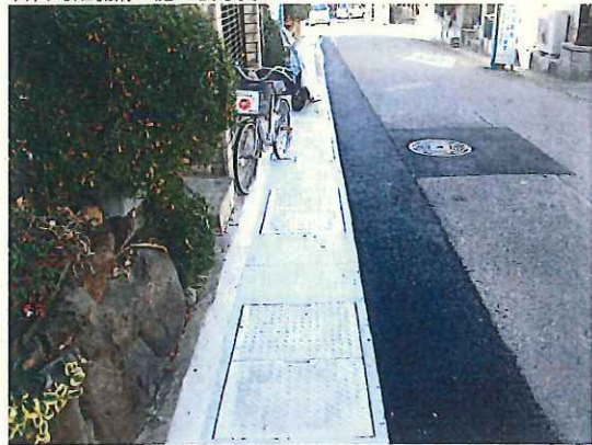
自由勾配側溝 施工後写真
