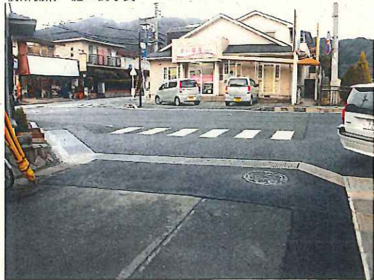
横断側溝 施工後写真
