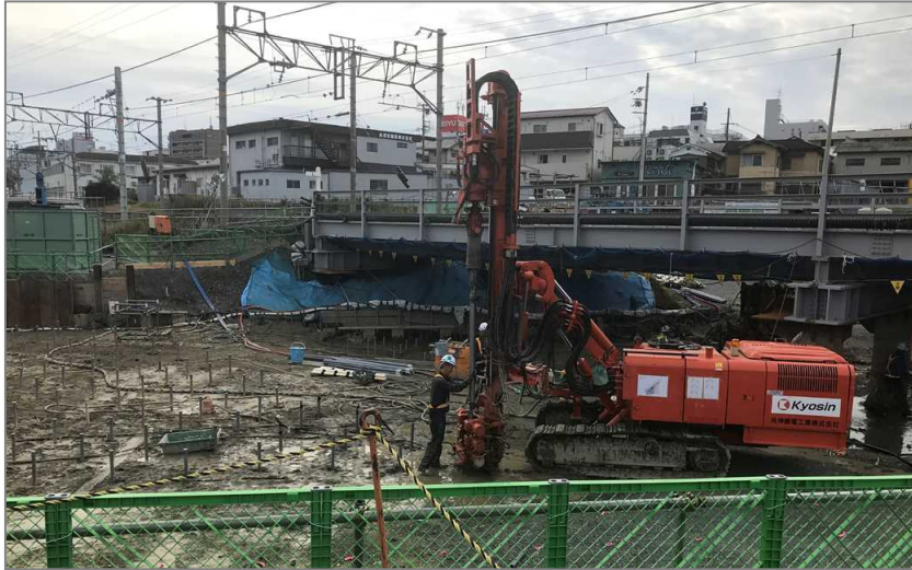
《外管挿入施工中》 平成 30 年 9 月 30 日撮影 写一1
