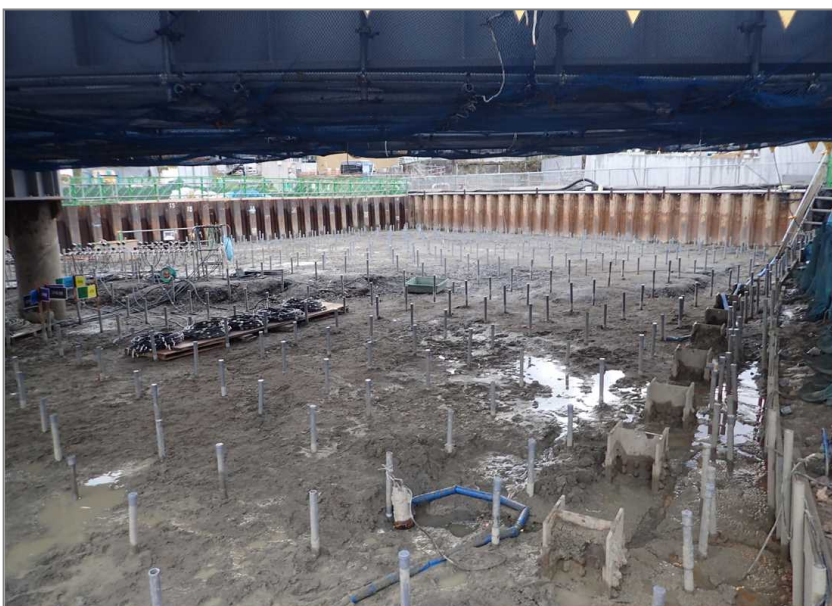
《1次注入施工中》 平成 30 年 10 月 15 日撮影 写一3
