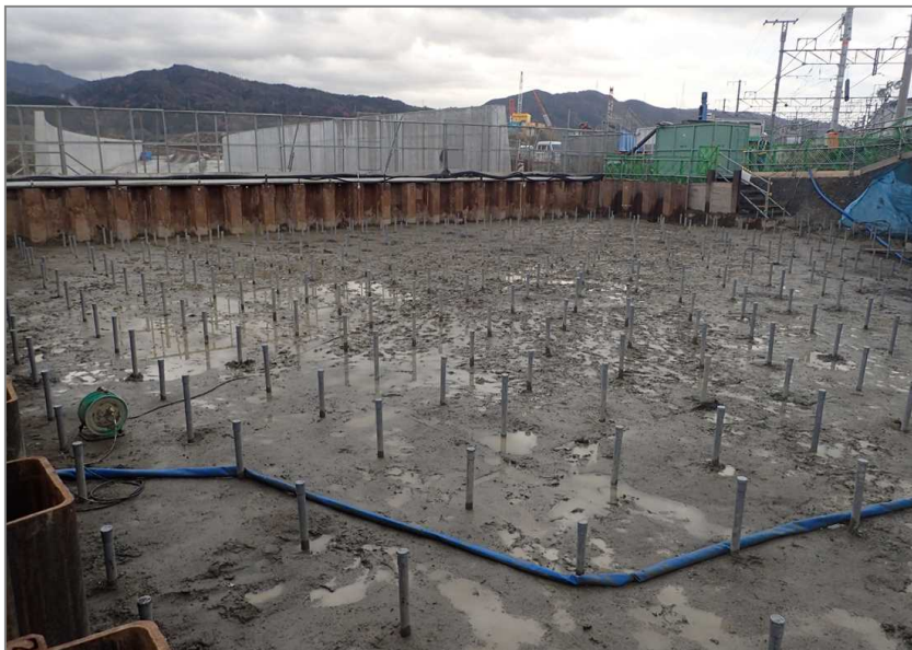
《外管挿入完了》 平成 30 年 10 月 15 日撮影 写一2
