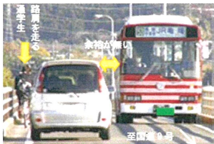
宇津根橋通行状況
