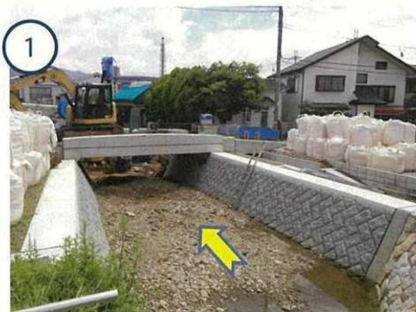
雑水川(架設中の北町橋)
