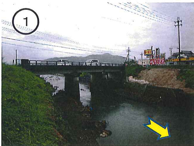
現状写真(未改修) 犬飼川右岸から上流 平成25年10月23日 午後1時30分撮影
