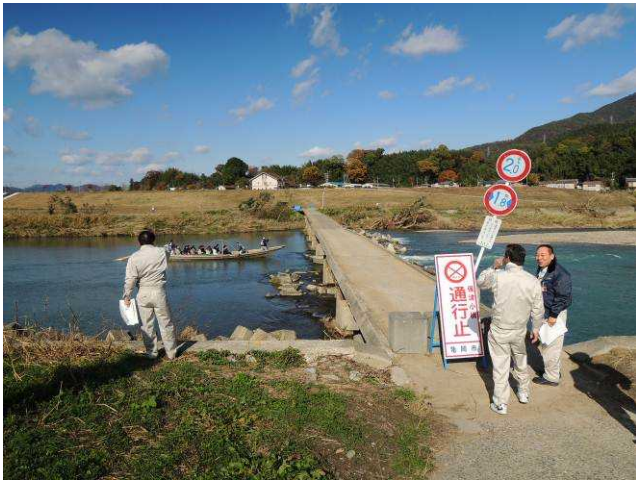
⑤桂川 保津小橋
