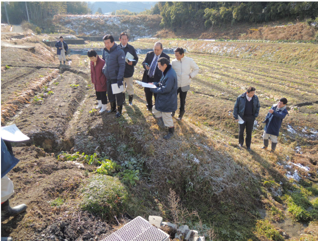
畦畔崩壊箇所（小災害）※資料（現地3-1）
