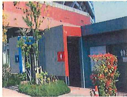
多目的トイレ
