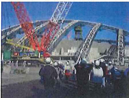
建設途中の工事見学会
