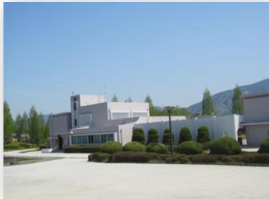
千代川浄水場
