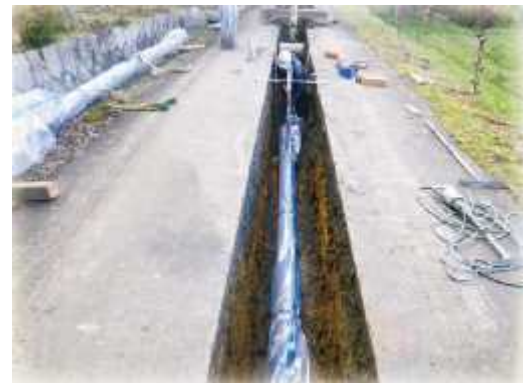
水道管の更新工事
