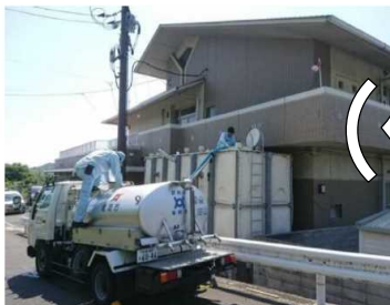
福祉施設の受水槽への給水活動
