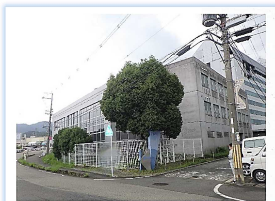
（現在の旧京都地方法務局亀岡出張所庁舎）
