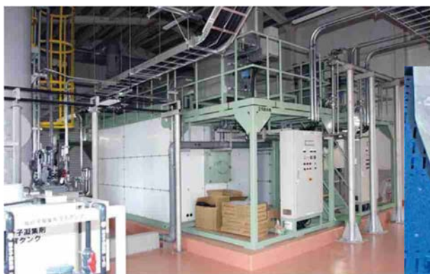
コンポスト施設(川東浄化センター)
