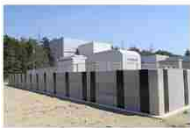
防水壁の設置
