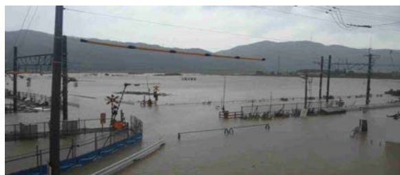
平成25(2013)年9月16日、台風18号被害。JR山陰本線保津踏切付近。写真左奥の三宅浄水場系取水井が水没、中央前方の保津浄化センターに浸水の被害が発生しました。写真右奥には年谷浄化センターがありますが、被害はありませんでした。
