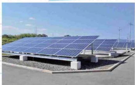
太陽電池パネル
