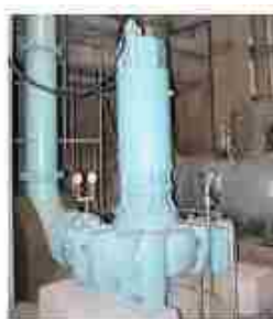
設備機器の防水化 (耐水型モーター)
