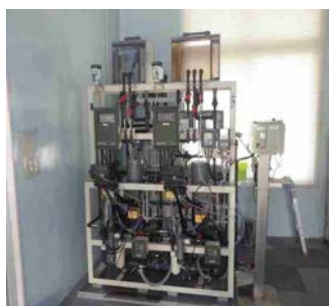
水質測定機器 (千代川浄水場)
