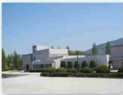
千代川浄水場
