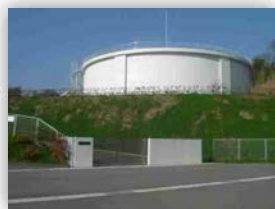
平和台配水池
