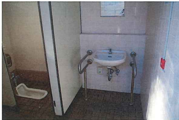
⑦ 洗面・小便器手すりあり 個室手すりなし
