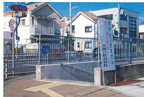
③ 国道9号地下通路入口
