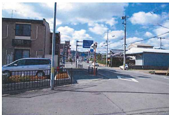
② 点字ブロック未整備
