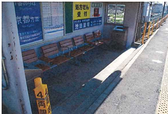
⑪ 上りホーム、駅待合スペース前に 段差あり
