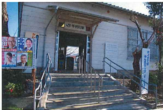
① 駅主出入口、高低差あり(階段8段) スロープによる別途アプローチなし
