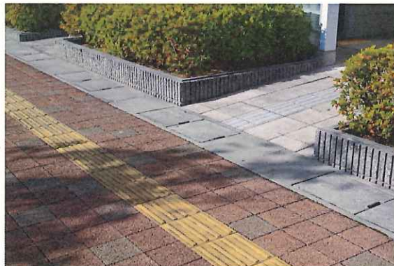
⑤ 歩道・トイレ間の点字ブロックが接続していない
