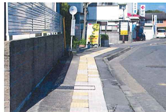
⑮ バス停部の点字ブロック
