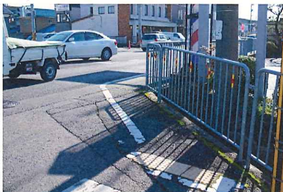
⑪ 交差点西側南、点字ブロックのみ敷設 歩道整備なし
