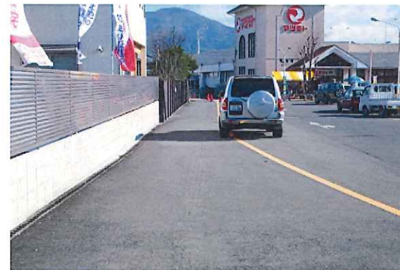
⑨ 点字ブロック撤去あと
