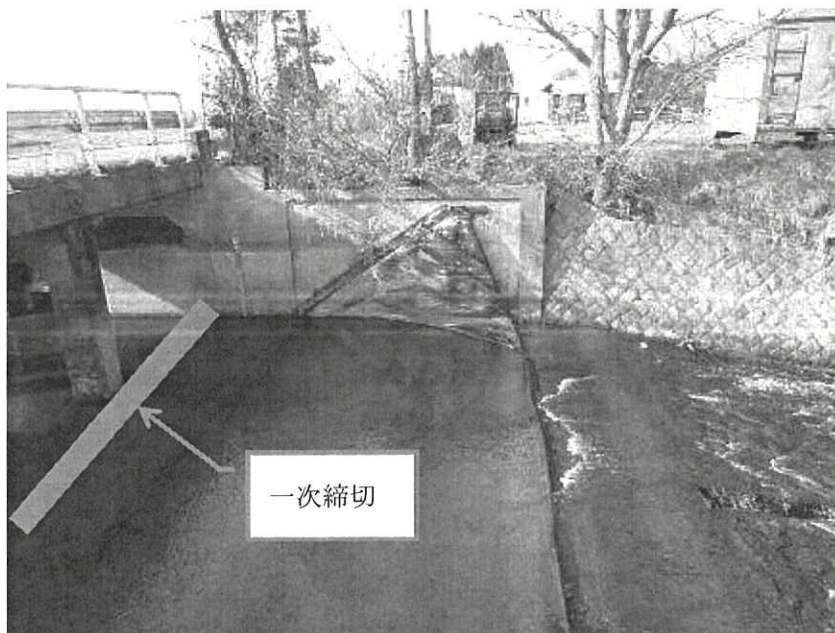
【写 3-1-2 一次締切設置箇所】
