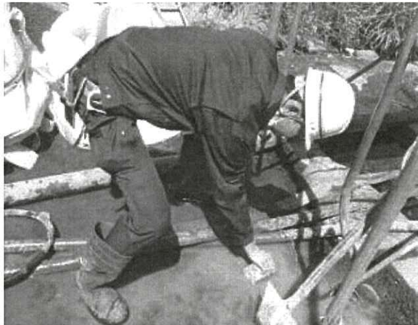
【写 3-1-6 コア抜き時採水状況】
