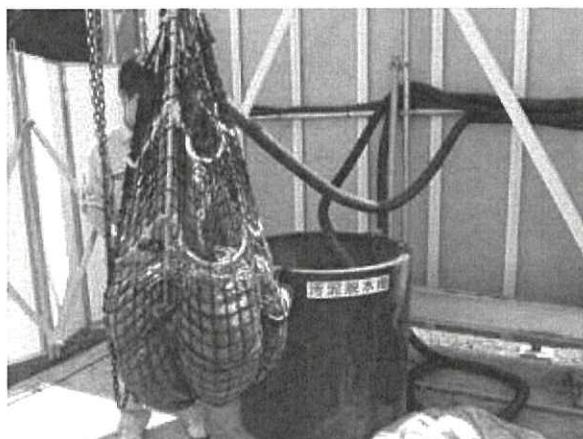
【写 3-1-3 排水濾過参考写真】
