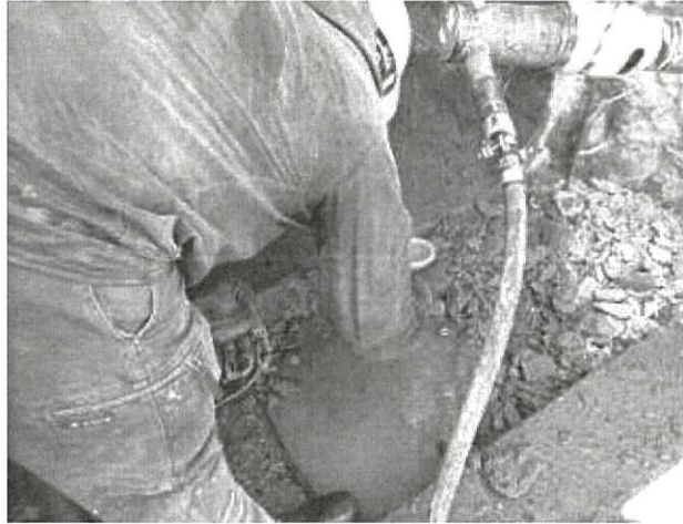
【写 3-1-5 ハツリ時採水状況】
