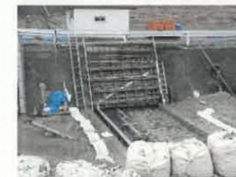
④アンカー設置
