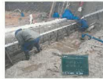
③底版補強筋設置
