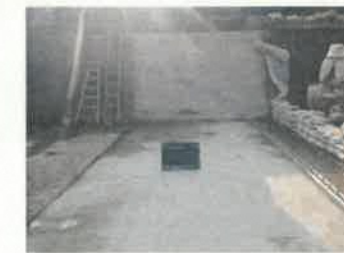
④コンクリート打設
