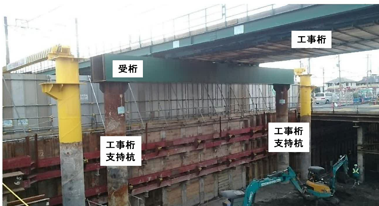
写真2-2 工事桁設置例
