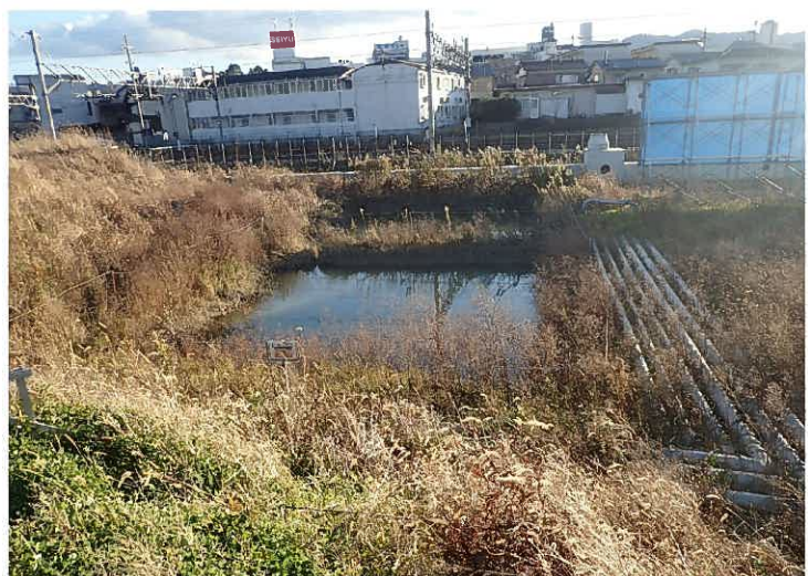
写 3-1 仮設沈砂地(組合工事により設置)
