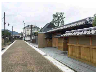
電線類を地中化した武家町エリア
