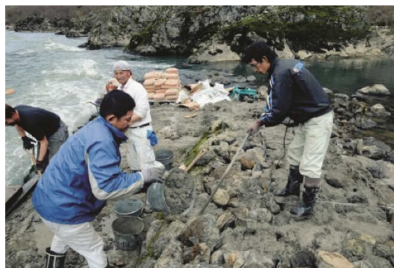
水寄せの修理
