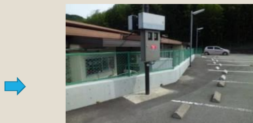
三角地拡大・ガード設置
