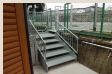
駐車場へ 直結通路新設
