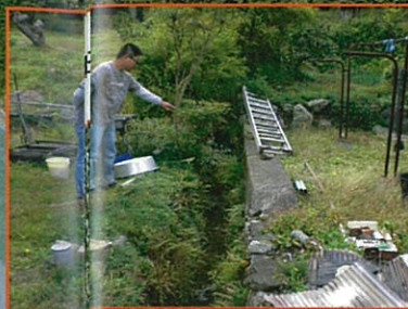
【中野八幡神社下流の水路】 ・大雨の時には水路が増水し、庭まで冠水する。
