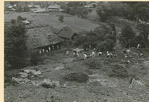
神前区の土砂崩れ現場の状況 多くの家屋が崩壊した
