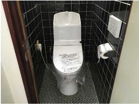
1階 トイレ 令和2年新品入替
