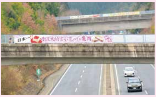
▲桜台跨道橋(南つつじヶ丘)
