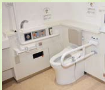
△新たに設置されたバリアフリートイレ
